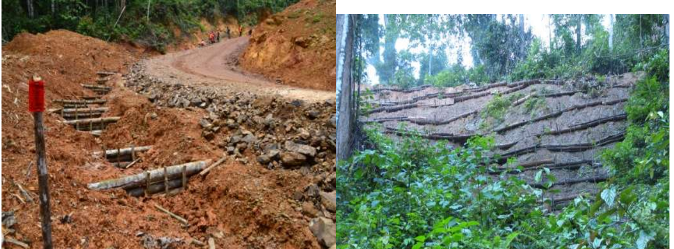
Gambar 11. Sedimen Trap dan Pembuatan Teras Penahan Longsor
