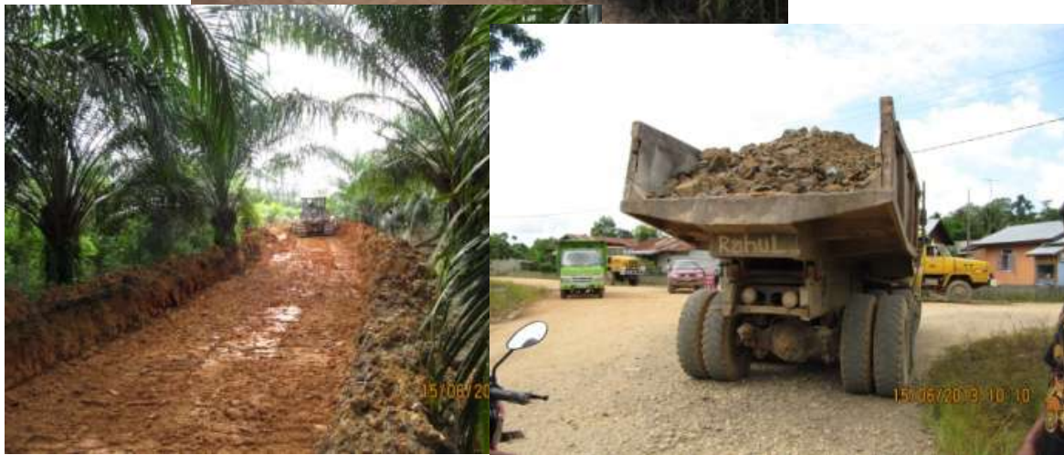
Gambar 14. Membantu Pembangunan dan Pemeliharaan Sarana dan Prasarana desa
